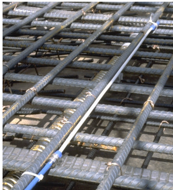
Abbildung 4: Vor der Einbetonierung an der Armierung befestigter SOFO-Sensor
