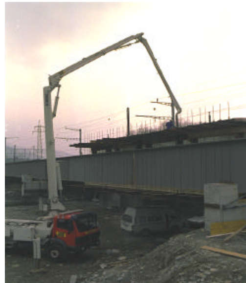
Abbildung 17: Moesa-Brücke, bei der Betonierung
