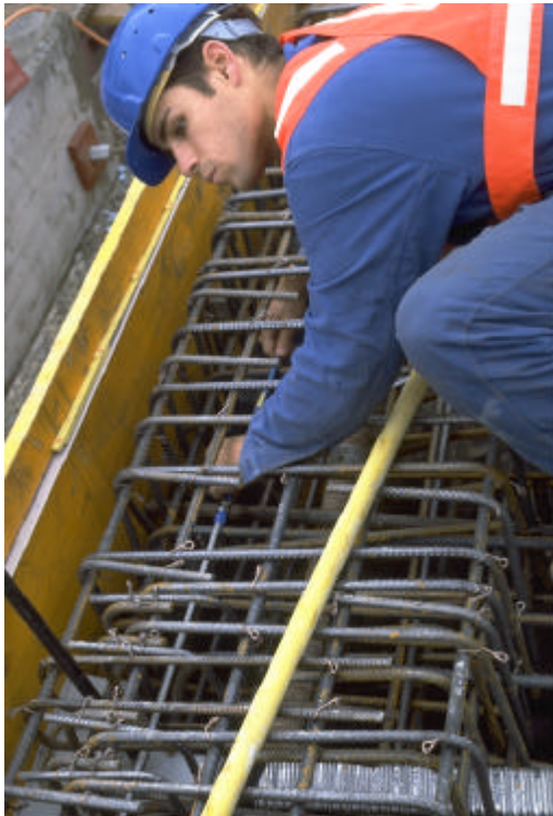
Abbildung 12: Installation eines SOFO-Sensors bei der Versoix-Brücke (GE)
