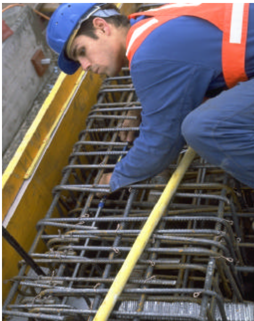
Abb. 5: Installation eines SOFO-Sensors bei der Versoix-Brücke (GE)
